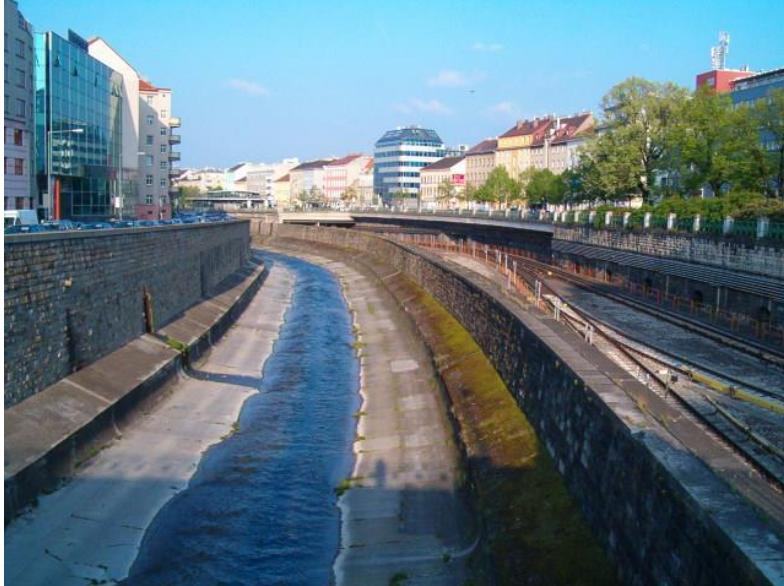
Tokom prosječno duže od 90 % vremena godišnje ovim bujičnim otvorenim vodotokom teče do  $1 \text{ m}^3/\text{s}$ . Kanal velikih dimenzija potreban je stoga, jer velike vode mogu dosegnuti proticaj od  $450 \text{ m}^3/\text{s}$  i više. Može se samo zamisliti kakvu bi štetu uzrokovala ta voda u urbanom prostoru središta grada Beča. U ovom slučaju sigurnost je bila prvi kriterij za rješavanje provođenja vode kroz grad.
