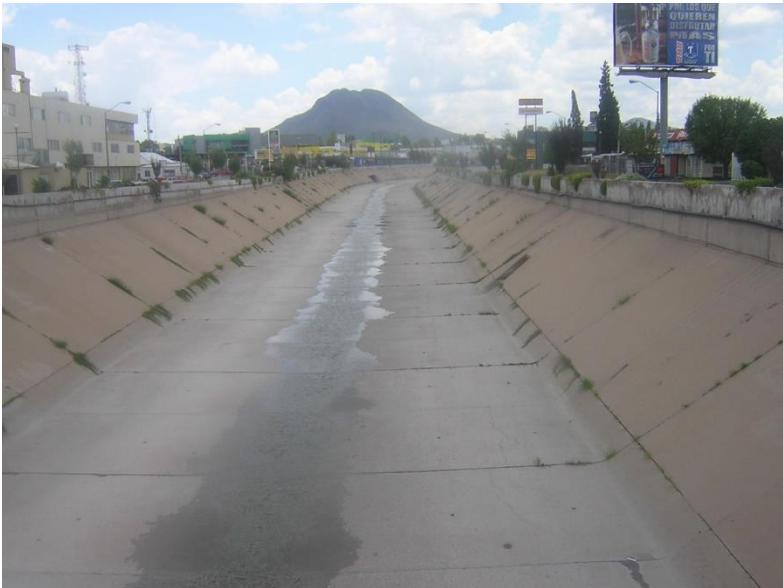
*Fotografija betonskog kanala otvorenog bujičnog vodotoka kroz urbano područje*
